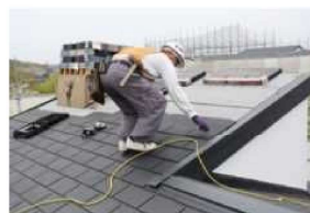
屋根の断熱化工事
